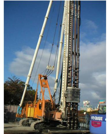
写真－1 高精度多軸オーガ掘削機
